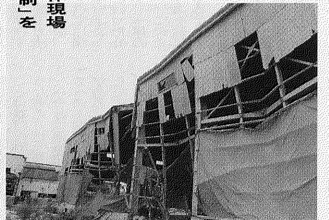
残骸となったスレートには無造作に破碎されたり、中には路盤材に使われているモノもある。
