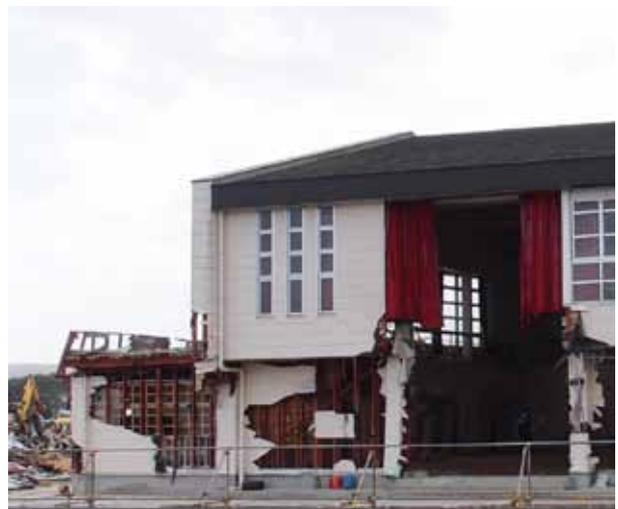
写真9:アスベスト含有建材の外壁(2011.6.16)
